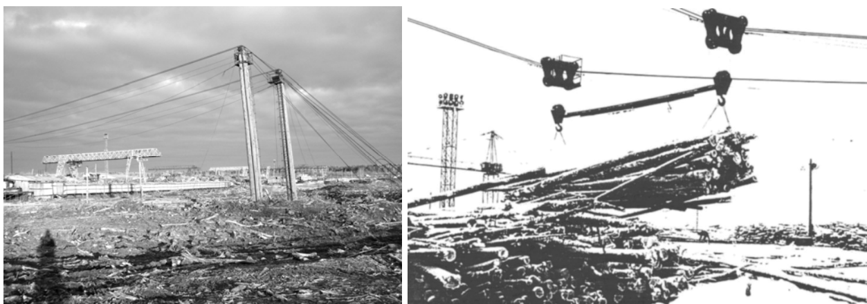
Рис. 2.20. Работа кабель-крана на нижнем складе [16]
